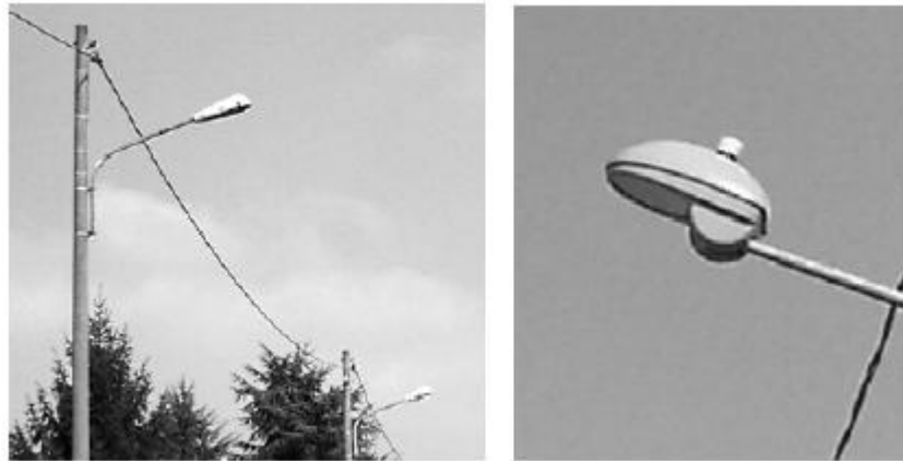
Figura 1: esempi di armature progettate inclinate (a sx) e da regolare per la posa in opera orizzontale (a dx)
