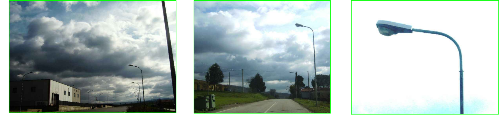
illuminazione stradale con armature poste su palo rastremato con sbraccio Lampade ai vapori di sodio (SAP)
