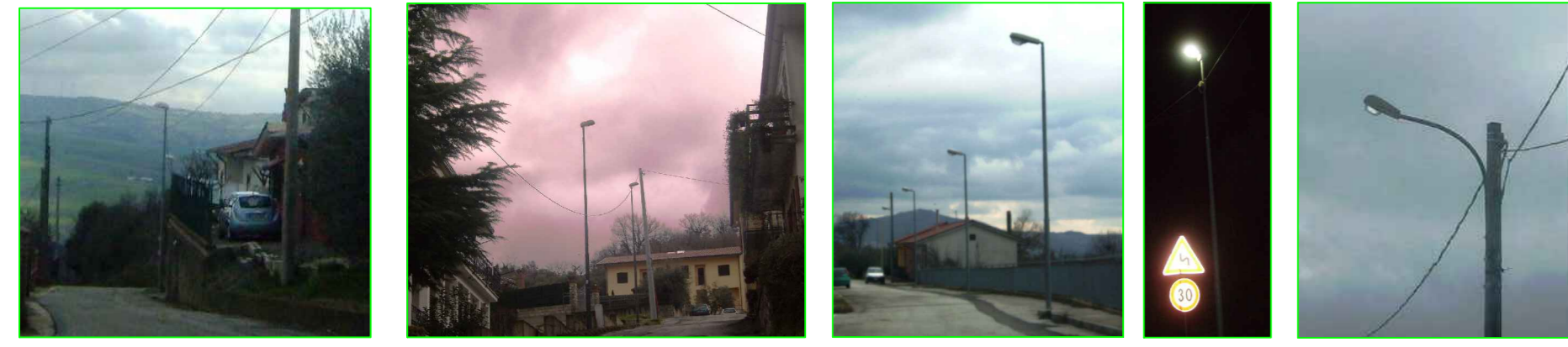
illuminazione stradale con armature poste su palo rastremato con sbraccio Lampade ai vapori di sodio (SAP)
