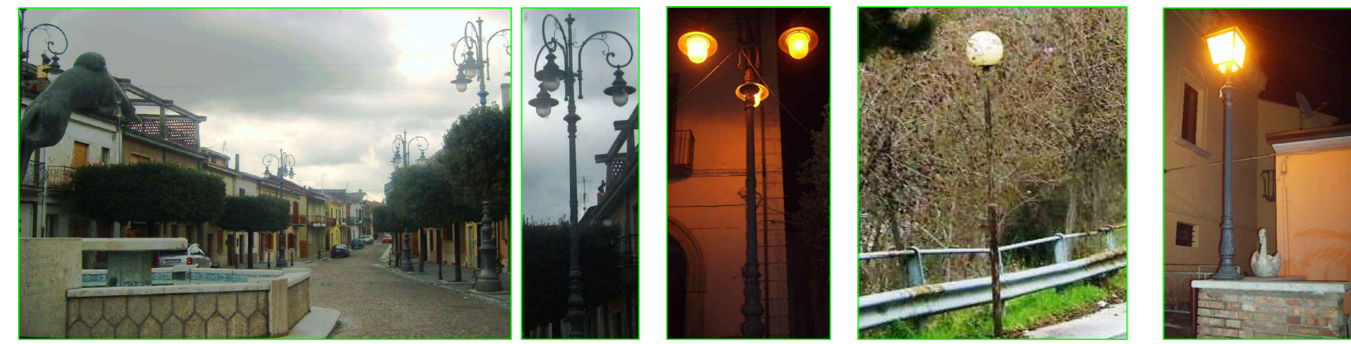
illuminazione su palo ornamentale o a parete, tipo a sospensione ovvero a lanterne o sfere Lampade ai vapori di sodio (SAP)
